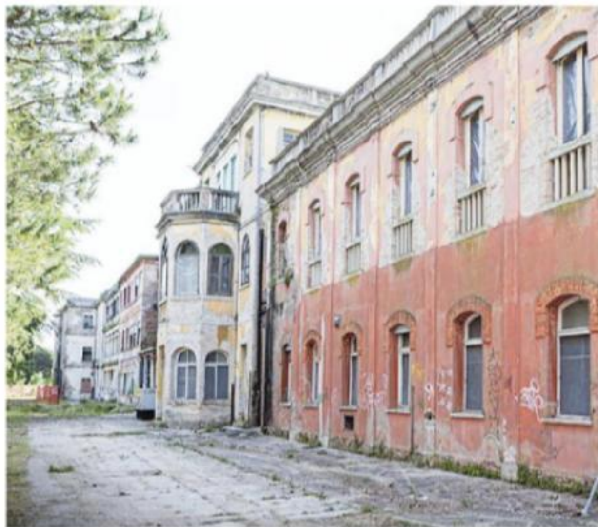
Degrado e abbandono dentro l'ex ospedale al Mare del Lido
