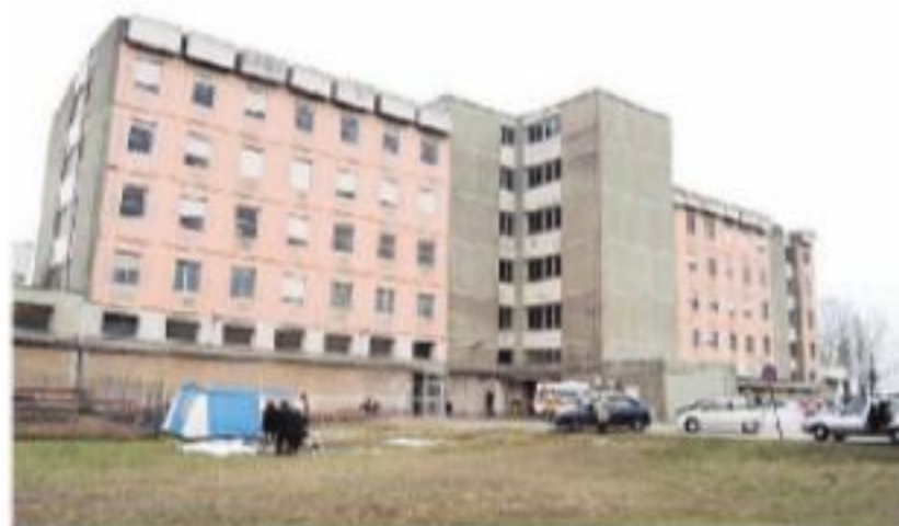
Il Monoblocco, sede del distretto sanitario del Lido
